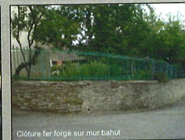
Clôture fer forgé sur mur bahut
