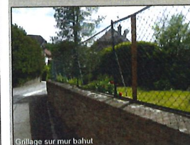
Grillage sur mur bahut
